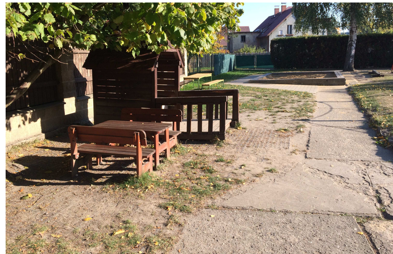
foto 8: Domeček je ve špatném technickém stavu, dřevo je v kontaktu s půdou a podléhá hnilobě. Betonové povrchy jsou rozpraskané a na několika místech nebezpečně vydrolené.
