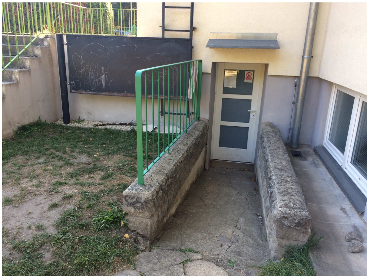
foto 5: Vstup ze zahrady do suterénu školky - rampový sestup do suterénu je zpevněný dvěma opěrnými zídkami z KB bloků, povrch rampy je silně degradovaný. Nalevo je patrný objekt vyvýšené terasy, která bude spolu se schodištěm demolována. Tabule bude demontována a umístěna na dřevěný plot v jiné části zahrady.
